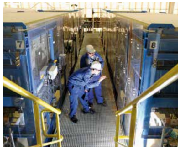
Ein speziell ausgebildetes Team sorgt für den professionellen Austausch der empfindlichen Membranen.
