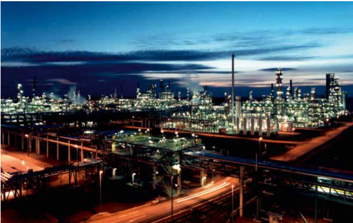
BUCHEN Safety Service für den gesamten Komplex der TOTAL Raffinerie Mitteldeutschland in Leuna.
